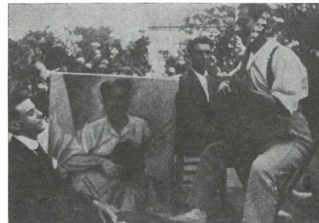
Fotografía tomada por Federico García Lorca. De derecha a izquierda Miguel Pizarro, Manuel Angeles Ortiz y Angel Barrios
