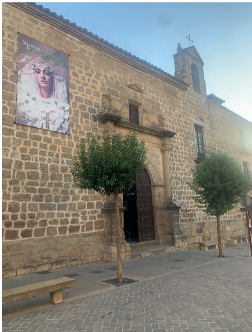
Fachada del monasterio.
