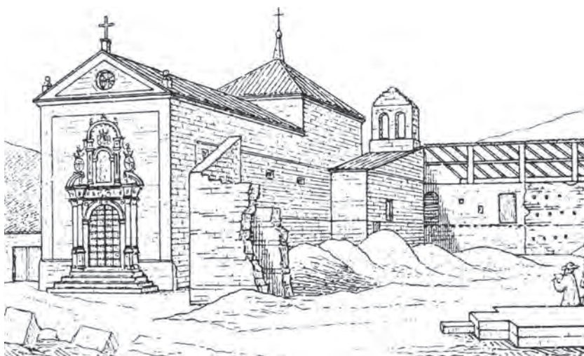
Restauración. Grabado que muestra Iglesia y monasterio derruido, finales del s. XIX.
