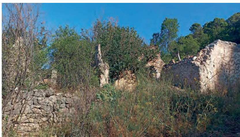
Ruinas de lo que fuera el convento de El Calvario.
