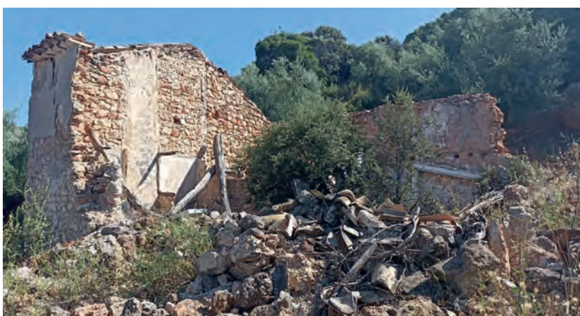
Ruinas de lo que fuera el convento de El Calvario.
