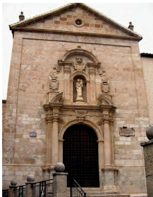
Fachada del monasterio.
