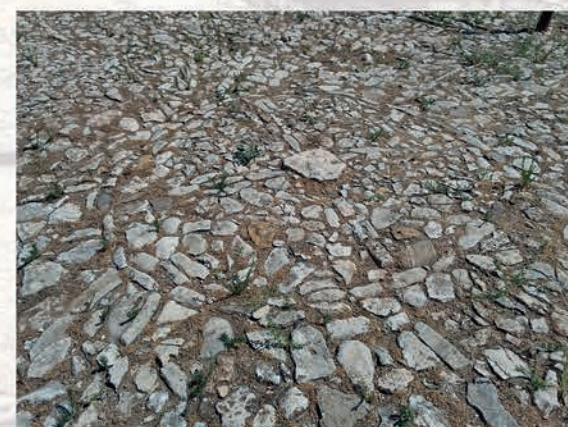
Detalle del pavimento de guijarros de era. Una loseta irregular ocupa el centro, caracterizado por un círculo con una cruz inscrita. De este círculo deriva un patrón de radios Cárcel de Arriba
