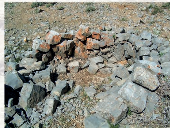
Muros de choza arruinada Almadén, Sierra Mágina
