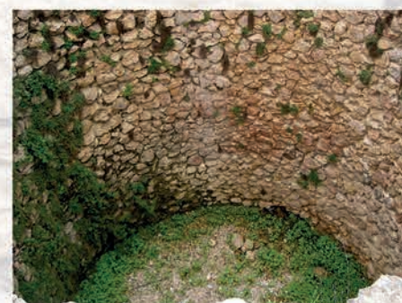
Interior de pozo de nieve rehabilitado Segura de la Sierra
