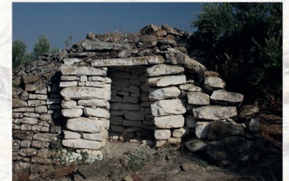
Guardahato encalado en el Pilarejo Porcuna
