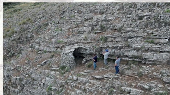
Chozo de Jabalena, Solana de Jabalcuz Construido aprovechando una pequeña pared rocosa Los Villares
