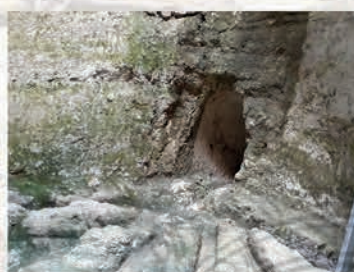
Drenaje en la base del pozo de nieve Fortaleza de la Mota
