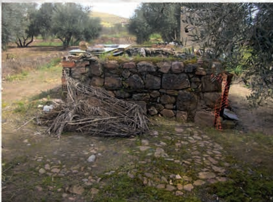
Base de noria de Quijailas Baños de la Encina
