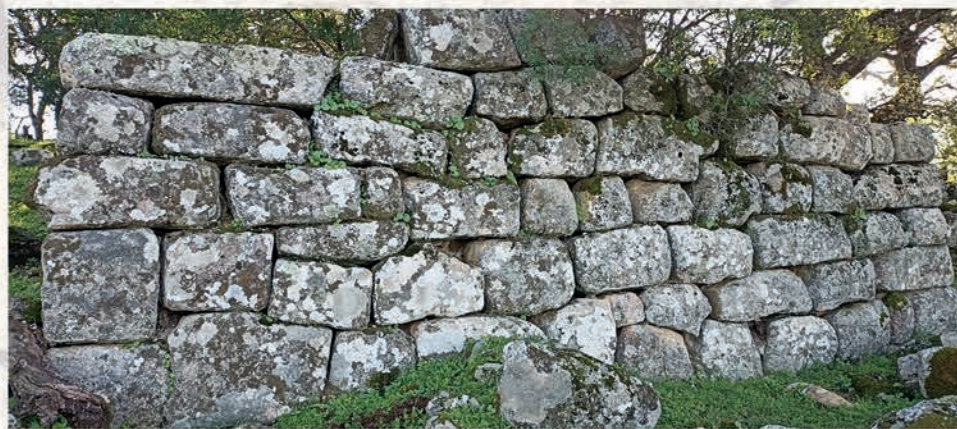
Muro ciclópeo de granito del Las Salas de la Galiarda asentamiento minero íbero-romano Santa Elena
