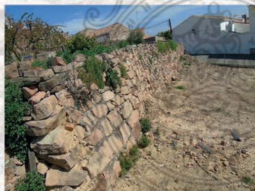
Tramo de albarrada reparada con cemento Baños de la Encina
