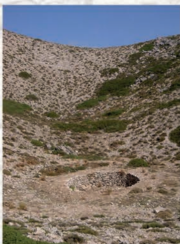
Pozo de nieve rehabilitado Huelma.
