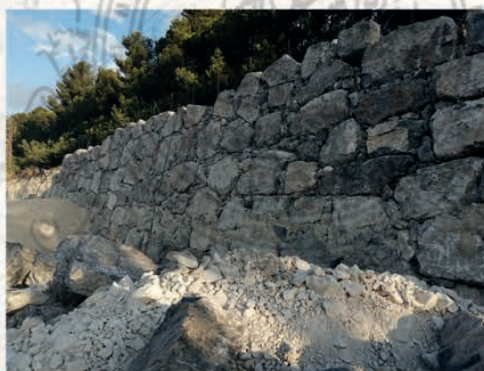
La piedra seca en la construcción moderna Muro de contención al oeste de la ciudad de Jaén
