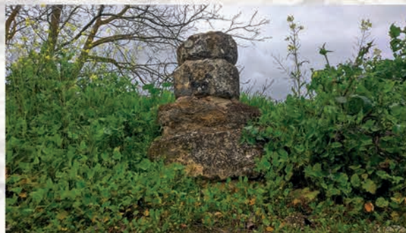
Chimenea de caracol en cortijo de Los Mangas Úbeda
