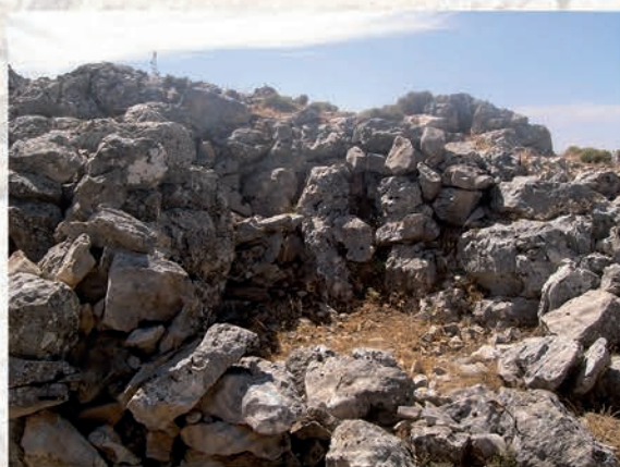
Muros de choza arruinada La Pandera, Los Villares
