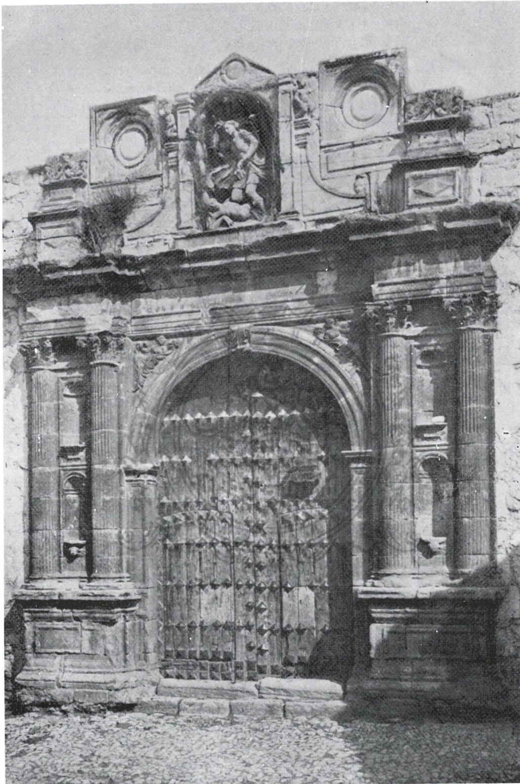
La portada de la iglesia parroquial de San Miguel, de Jaén, antes de ser desmontada para su colocación en el Museo Provincial.
