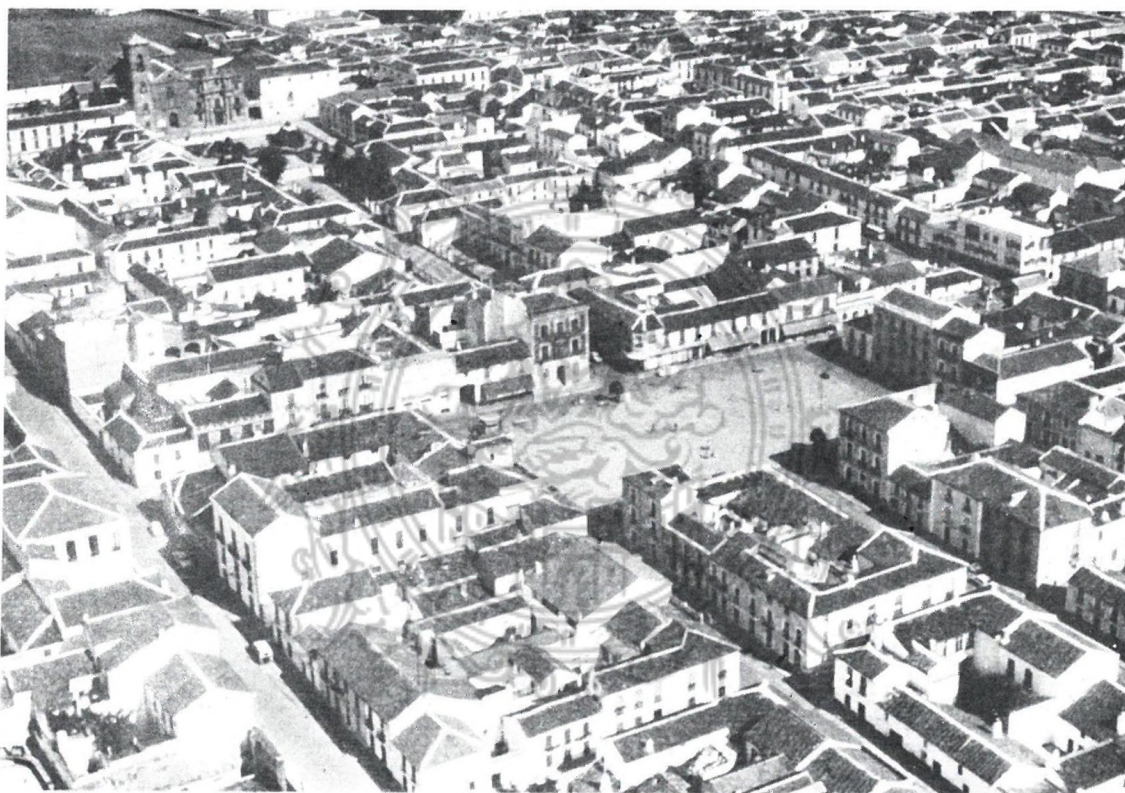
Vista aérea de La Carolina.
