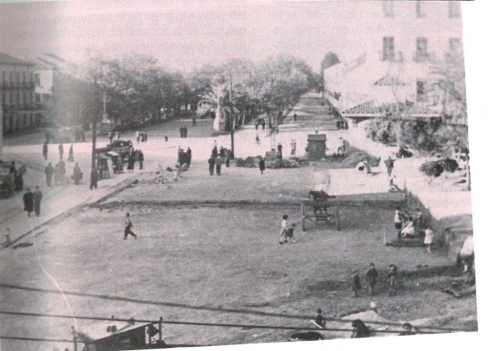
Cronología en imágenes del asedio «modernizador» al enclave de Santa Margarita. Arriba del todo, cuando todavía se llamaba Paseo y se prolongaba en el de Linarejos casi sin solución de continuidad. Sobre estas líneas, durante las obras que lo redujeron a plaza restándole parte de su superficie en beneficio del tráfico rodado. Abajo, situación actual: no sólo se han visto considerablemente mermados los jardines sino que el inmueble de Destilerías Romar (las casas de Villanova) cayeron bajo la picota para dar paso a un mamotreto de altura acorde con los que axfisian el Paseo
