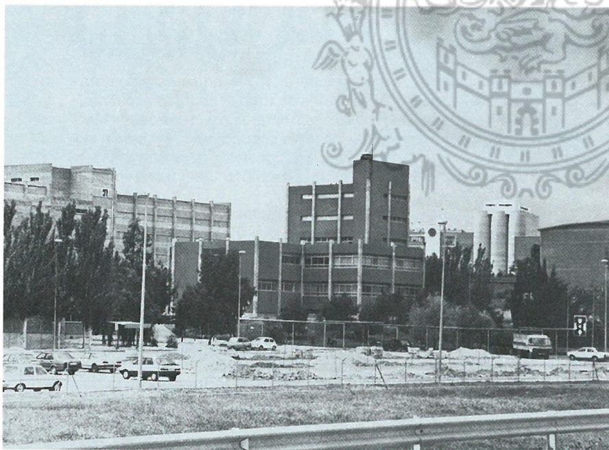
Una perspectiva de las actuales instalaciones del Colegio Universitario «Santo Reino» de Jaén
