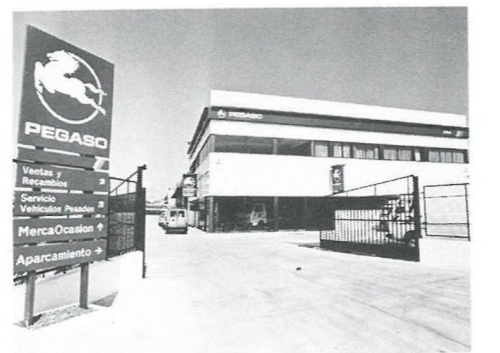
Vista general de las nuevas instalaciones de Jadisa.
