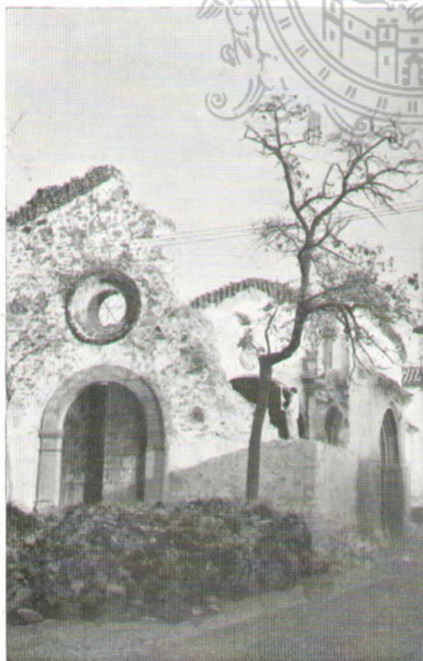
Obras de la Iglesia de Santa Cruz.
