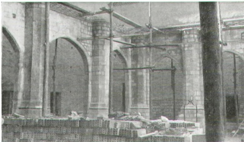
Vistas de las obras del claustro
