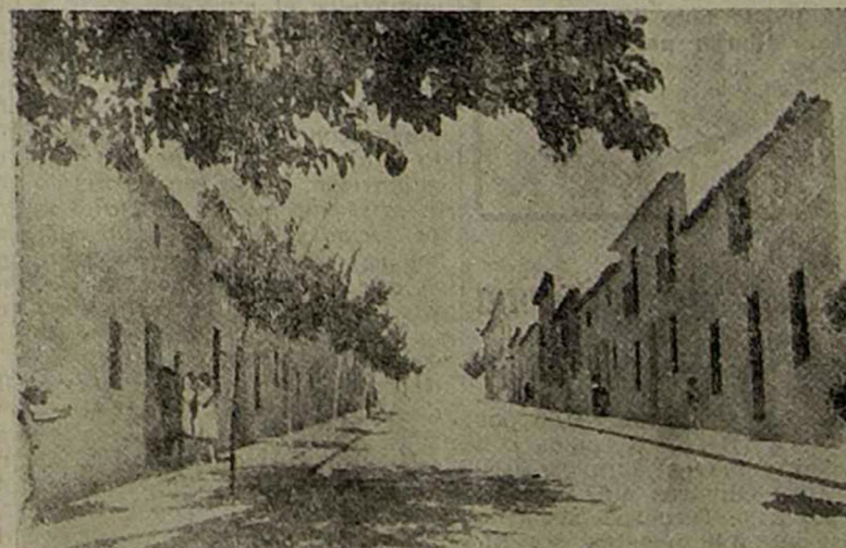
Vista parcial de la calle Ayala con la nueva pavimentación y acerados
