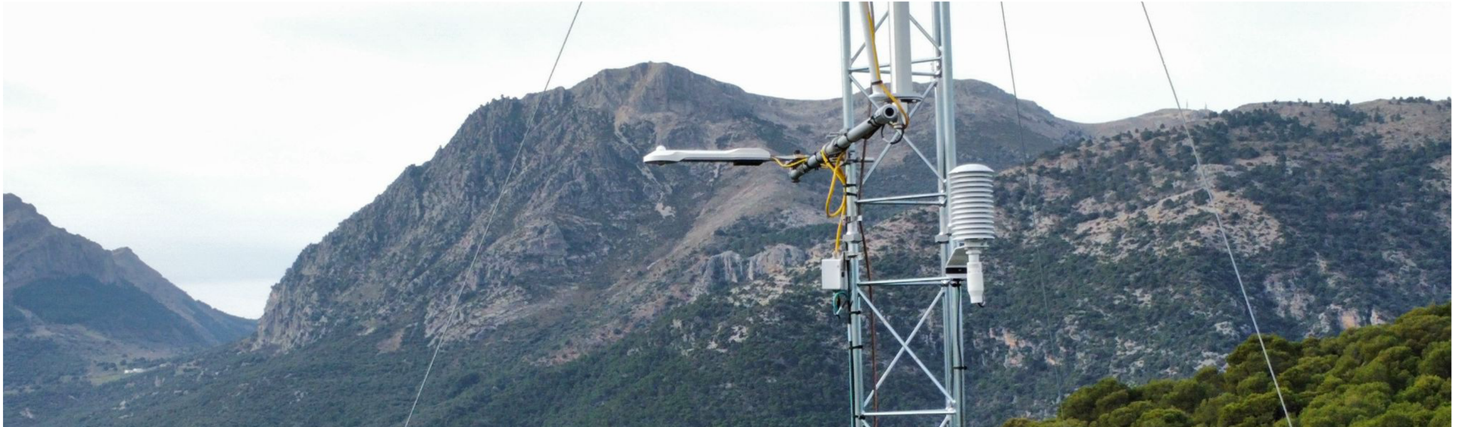
Sistema de medición del proyecto Establecimiento de programas de monitoreo de indicadores de biodiversidad y servicios ecosistémicos conectados a estaciones de seguimiento de cambio global en el sureste de la Península ibérica en la zona de La Chimba, en Jaén capital.
