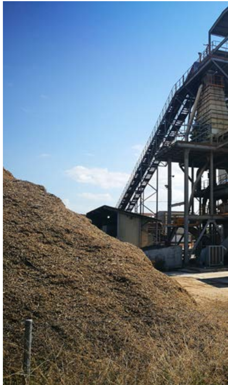
Imagen de una planta de generación de energía eléctrica con biomasa del olivar.
