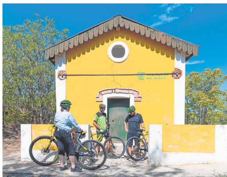
Casilla de ferroviario rehabilitada en la Vía Verde del Aceite
