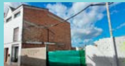
Vivienda 2. Corredera 21: Demolición
