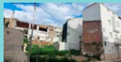
Vivienda 41. Manuel de la Chica 4: Demolición
