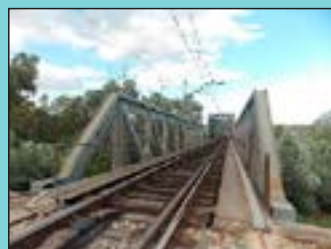
PUENTE DE HIERRO
