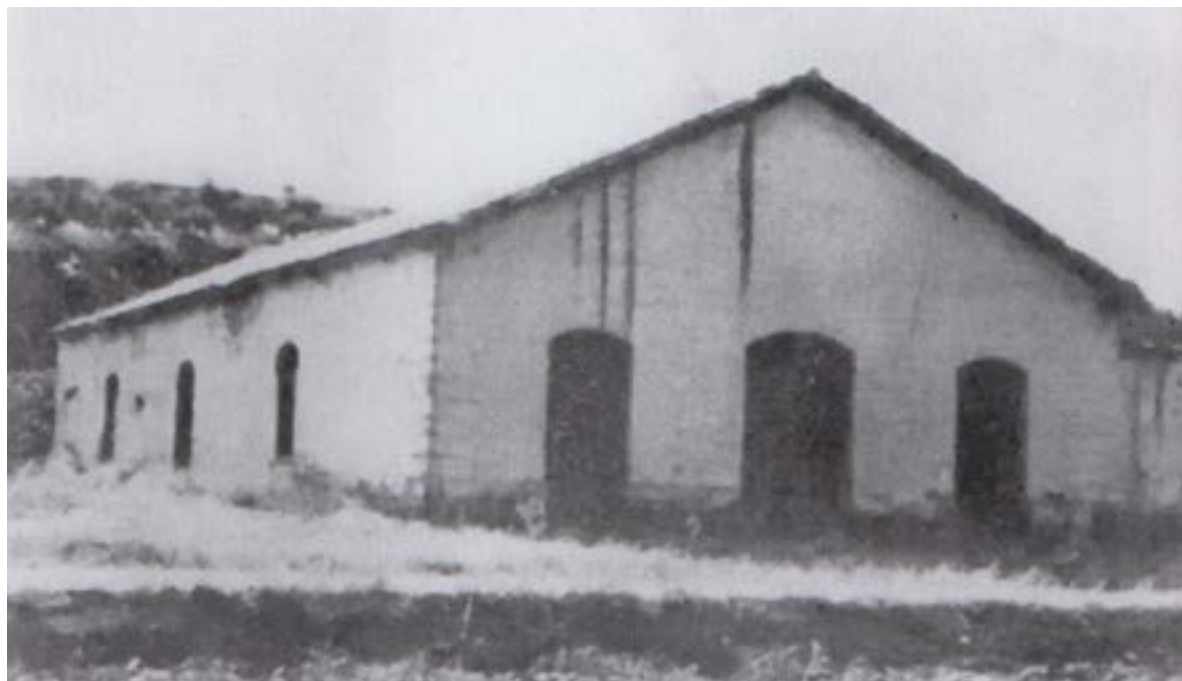
Img. 86 _Industria de maderas “La Bética”, ubicada en las cercanías del Barco de Mengíbar y demolida a finales del siglo XX.
