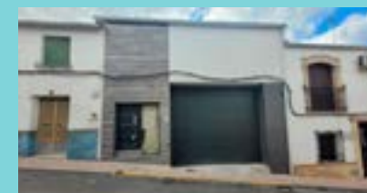
Vivienda 27. Cid Campeador 12: Sustitución
