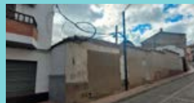
Vivienda 25. Los Montoros 16: Demolición
