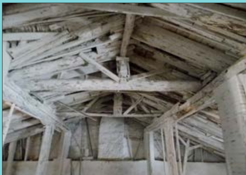
Img. 113_Cubierta de madera en el espacio de la cámara en la vivienda en Corredera 35
