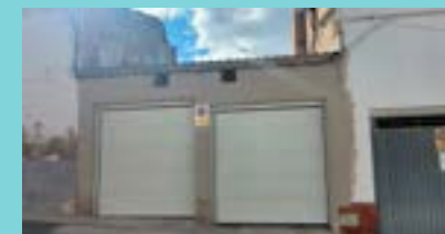
Vivienda 14. La Pompa 16: Demolición + sustitución
