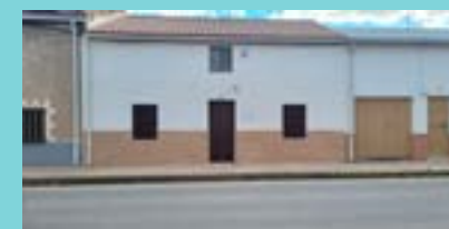
Vivienda 50. Santa Amalia 10: Rehabilitación
