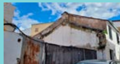
Vivienda 18. Bernardo López 13: Demolición
